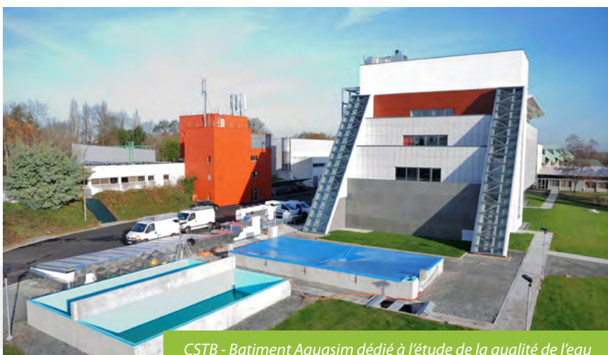
CSTB - Batiment Aquasim dédié à l'étude de la qualité de l'eau
